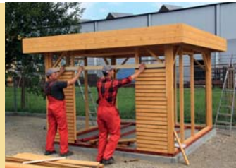
Anbringen der Rhombusschalung
