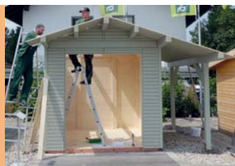
Erstellung der Dachschalung
