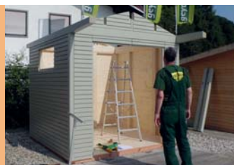
Einsetzen der fertig montierten Wand- und Giebelelemente
