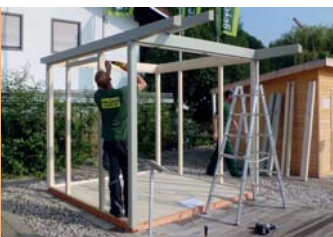
Aufbau der Skelettstruktur
