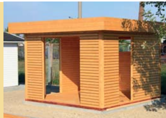
Dach- und Wandschalung
