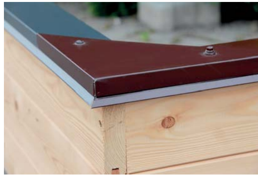
Blechabdeckungsvarianten EPDM Folie (Farbe grau oder braun, siehe Abbildung)
