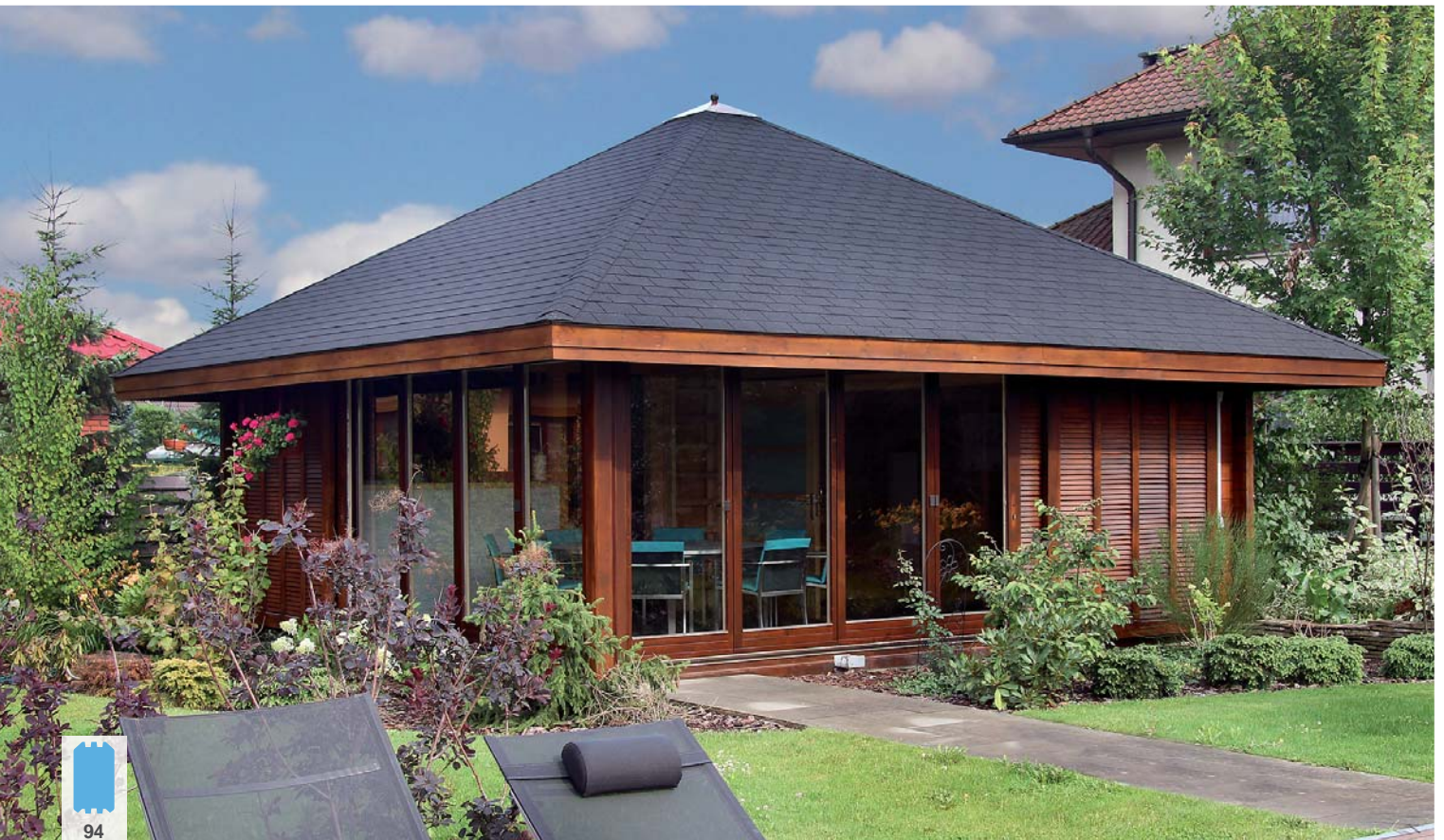
Fensterverschattung wurde nachträglich durch den Kunden angebracht
